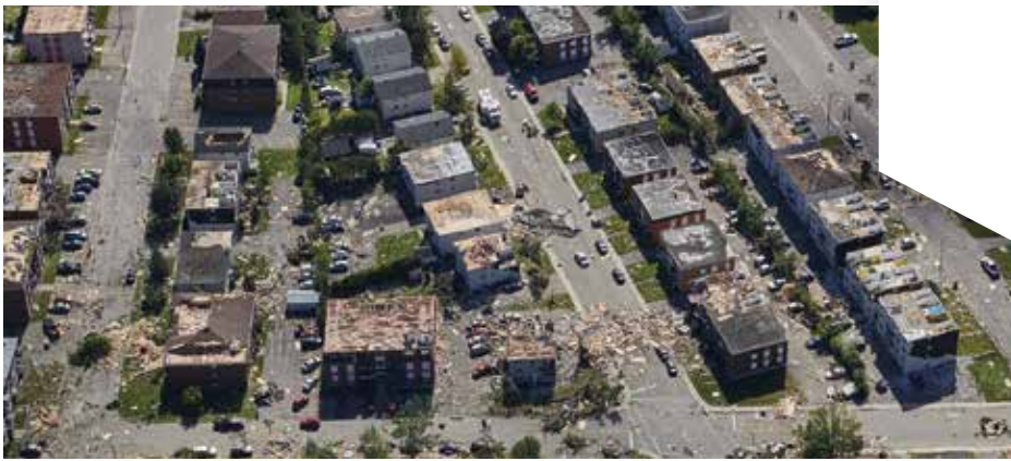
Scène désolation au cœur du secteur Mont-Bleu, à Gatineau, où des toits ont été arrachés, des voitures et des poteaux d'électricité ont été renversés. Crédit : Sébastien Lavallée, collaboration spéciale, Le Droit .
